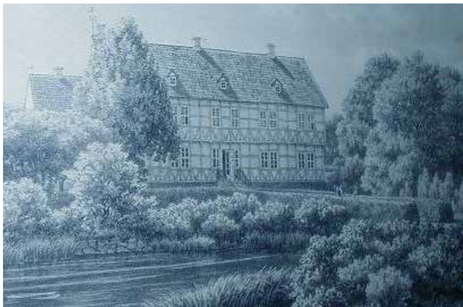
Den gamle bindingsværks hovedbygning opført af Johanne Oxe i 1575 og nedrevet i ca. 1875.
