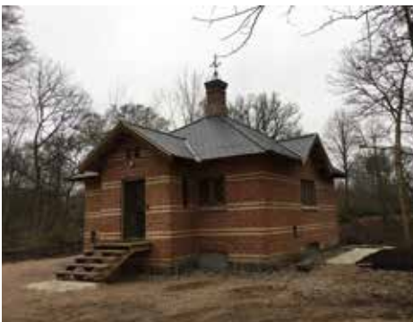
Høsehuset fra ca. 1875, blev 2017 gennemgribende renoveret og ombygget til en bolig.
