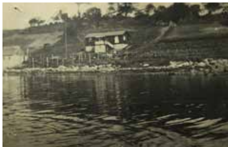
Huset blev bygget af elementer, der blev sejlet til stedet fra Holbæk.
