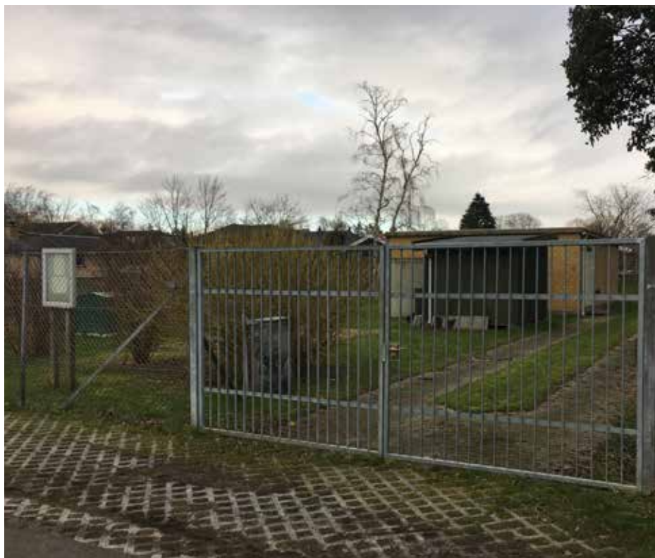
Indgangspartiet til Ejby Strand Vandværk set fra Hellesvej 22, Ejby
