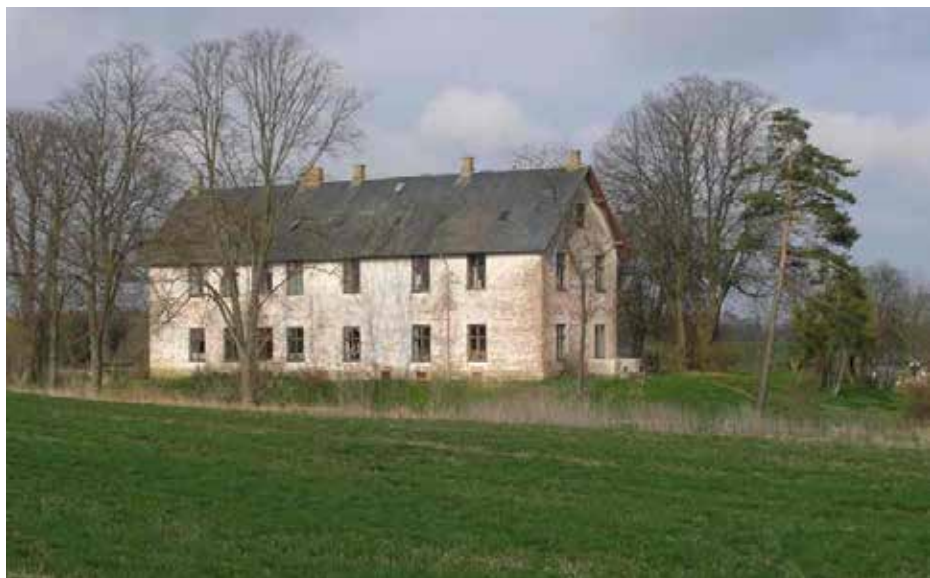
Hovedbygningen til Trudsholm Gods
